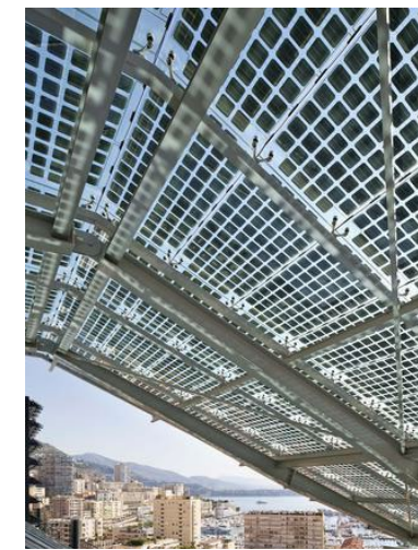
Monaco – 406 m² - 35 kWp
